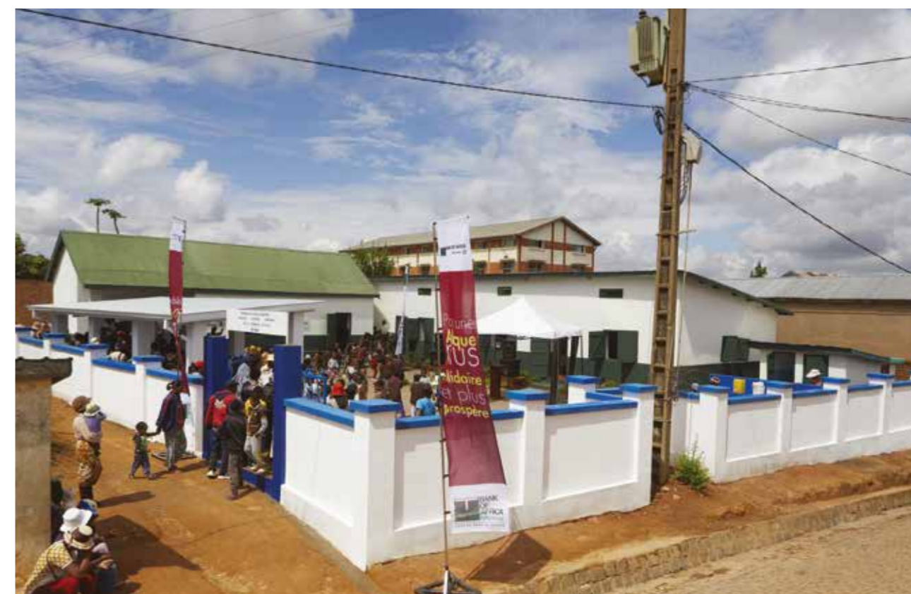
Rénovation d'une école primaire
